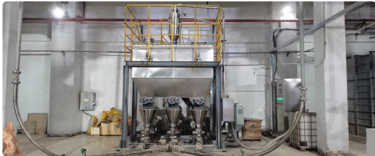
◆ 炉内 PNCR 高分子脱硝系统
