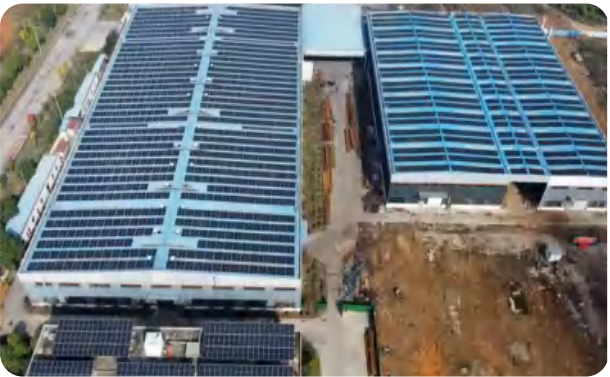
芜湖明特威光伏发电项目
