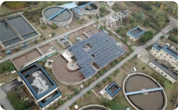
安庆清源污水处理厂光伏发电项目
