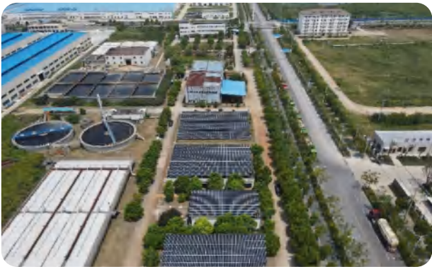
安庆宜源污水处理厂光伏发电项目
