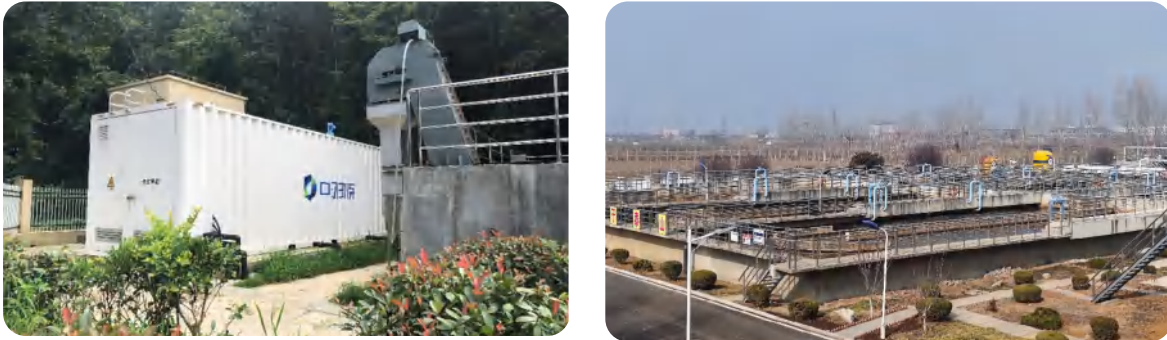
中环环保污水处理技术项目应用
