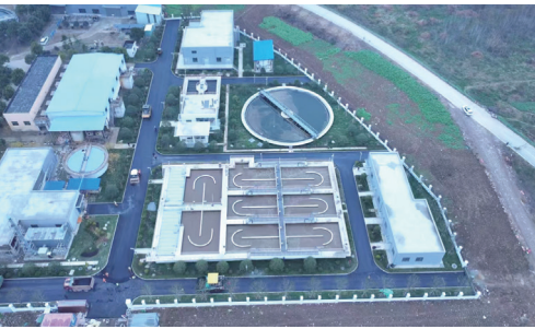
全椒清源扩建现场图
