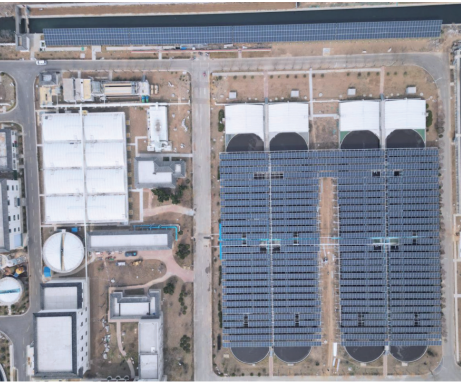
宁阳污水处理厂光伏面板铺设图
