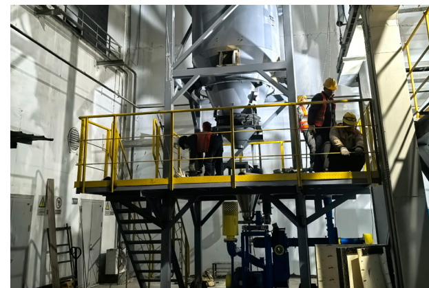
郸城电厂脱硫技改现场设备
