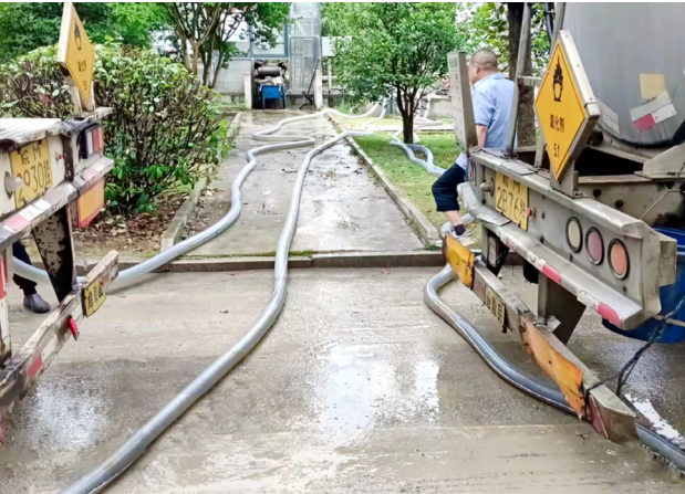
现场应急处理
